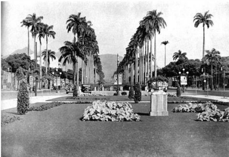
Canal do mangue depois da urbanização.
